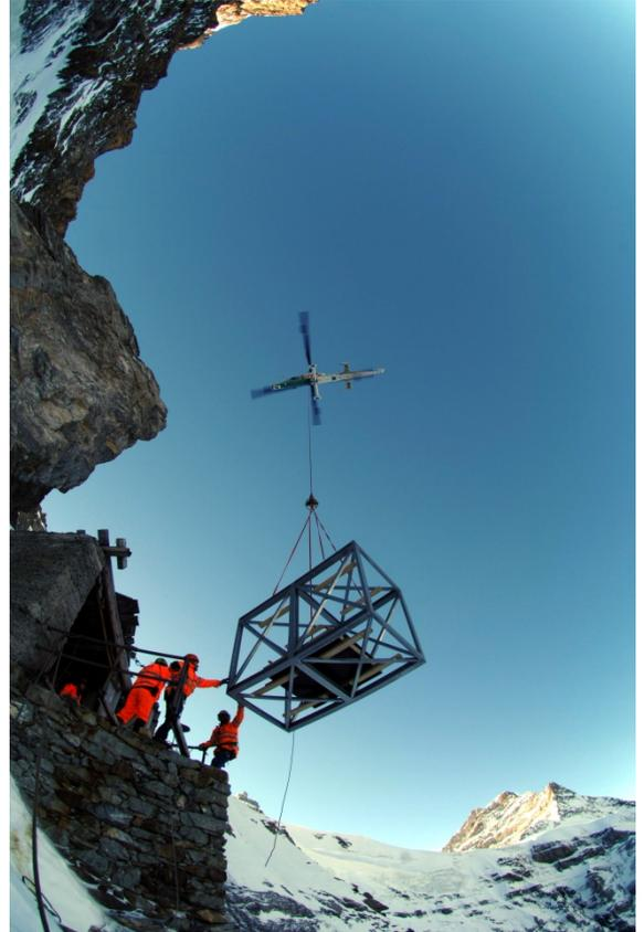
Fig. 4: KAMAN K-1200 "K-MAX" con TLP\_55\_30 (WLL 30 kN).
