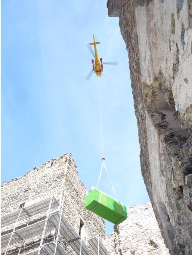
Fig.: AS 350B3e Heli Bernina AG con TLDS+\_14\_30 (WLL 14 kN).
