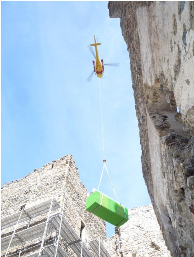
Fig. 3: AS 350B3e Heli Bernina AG avec TLDS+\_14\_30 (WLL 14 kN).
