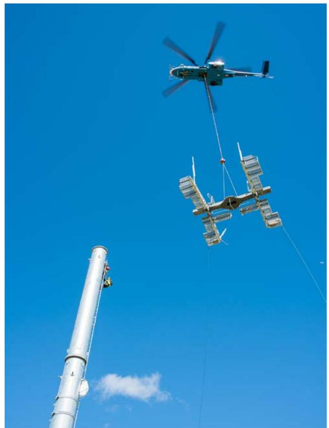
Fig. 2: Airbus H225, aiRtelis France, avec TLL\_50\_30 (WLL 50 kN) © Foto Julien Botella
